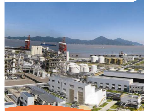
万华化学集团蓬莱海水淡化项目 Wanhua Chemical Group's Penglai seawater desalination plant
