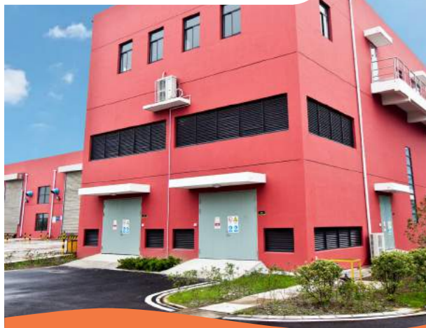
苏州工业园区污泥干化项目 Suzhou industrial park sludge drying project
