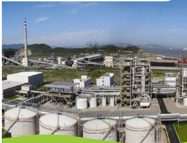
万华烟台工业园综合废水处理装置及浓水深处理
